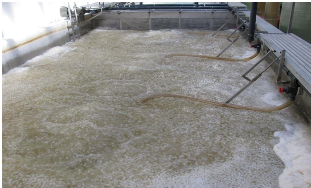
Биофилтър с плаващи пластмасови пълнители
